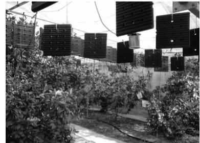
図1. 潜熱蓄熱材の設置状況
